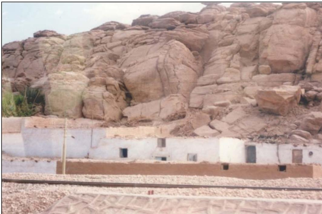
**Photo 4 - Fissurations verticales et horizontales sur le versant du talus et les masses tombées sur le versant d'Abou er Rische.**
