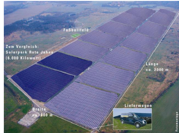
Figure 3 : Centrale Solaire de Brandis en Allemagne.
