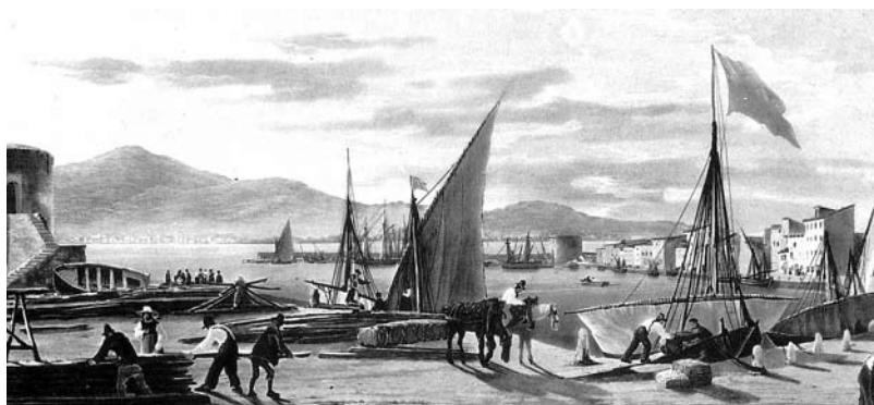
FIG. 3. – Chantiers navals de Saint-Tropez au début du XIX e siècle.
