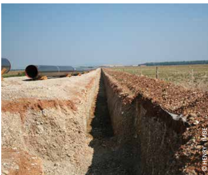
Régilage de la terre végétale sur géotextile en prévision de la restauration du sol des coussouls après installation d'une canalisation enterrée
